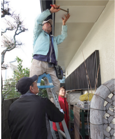
家屋の補修工事をする「助け愛ネット」のメンバー
